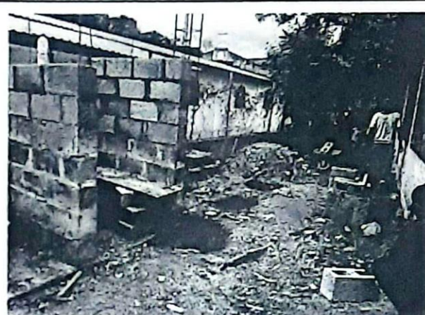
Foto 2. Mejoramiento y continuación de construcción con block.
